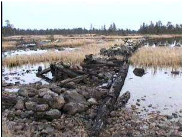
Flottningsvall av stenkistor vid SO-hörnet av udden (hösten 2003)
