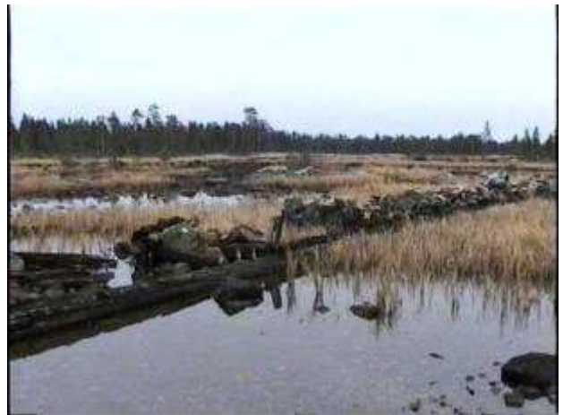
Flottningsvall av stenkistor vid SO-hörnet av udden (hösten 2003)
